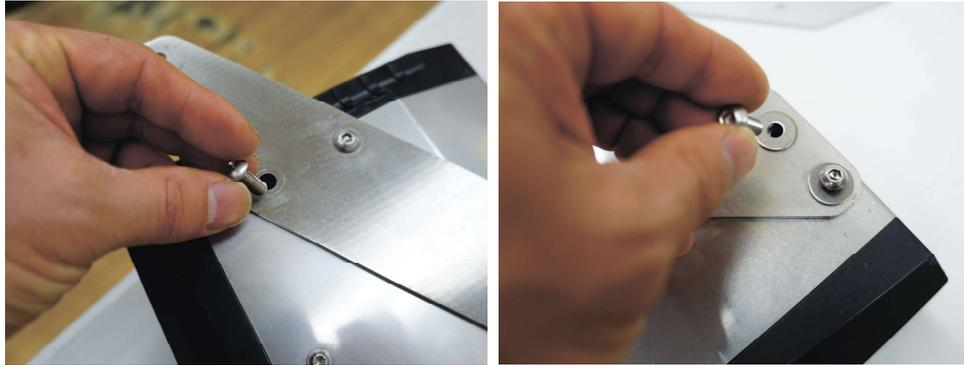
← ツールボックスを仮止めします (取付ビス使用 (まだビスを締め込まない) ※1
